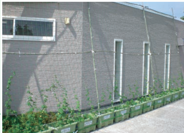
ネットを張りプランターに苗を植え緑のカーテンづくり。
